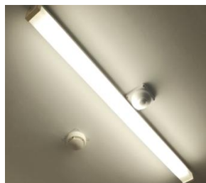
เครื่องตรวจจับควัน / ความร้อน และหัวกระจายน้ำดับเพลิง
